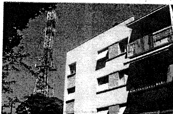
Le pylône de Bonheure, emblème du combat que mènent des centaines d'habitants contre les antennes-relais à Toulouse.
